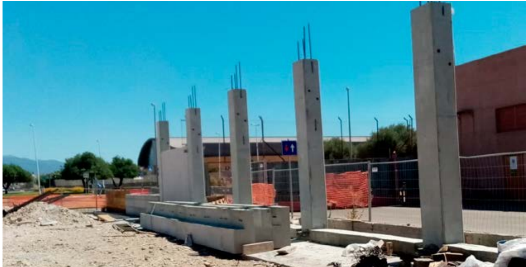
INIZIO DEI LAVORI DI MONTAGGIO: 20 LUGLIO 2022
